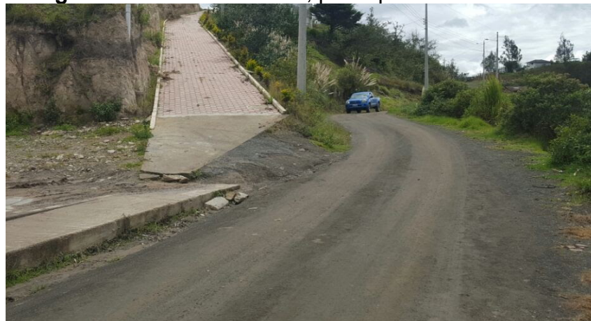
Fotografía 33. Vías lastradas, parroquia de La Unión
