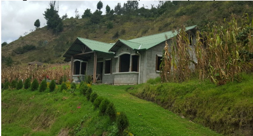
Fotografía 25. Vivienda de Bloque, Centro parroquial
