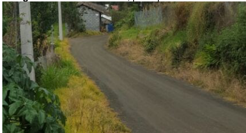
Fotografía 34. Vías lastradas, parroquia de La Unión
